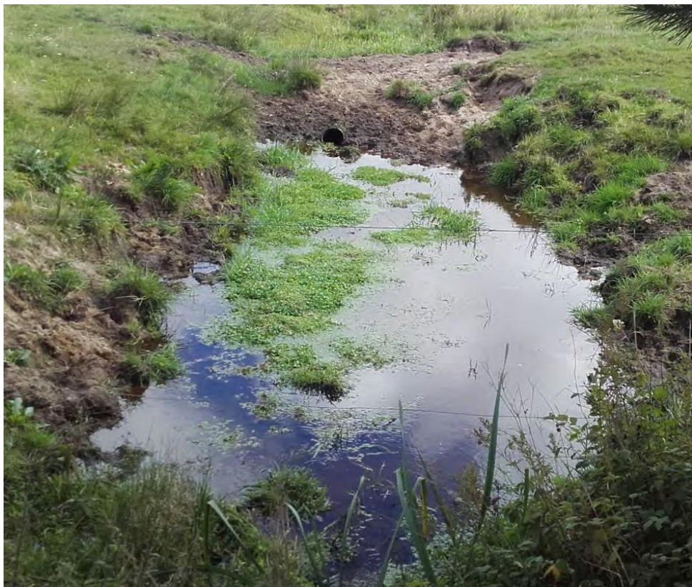
Figur 6-7. Den baljeformede, ny opgravede del af grøften.
